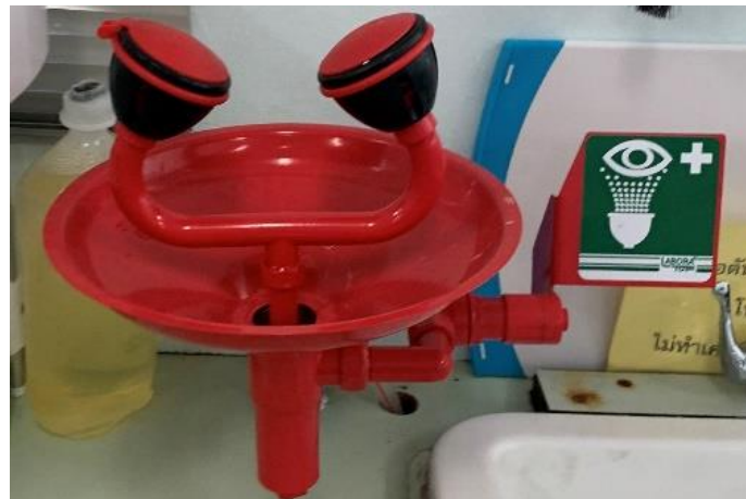
รูปที่ 29 อ่างล้างตาฉุกเฉิน
