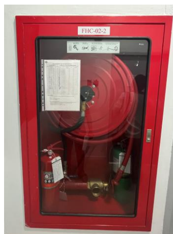
รูปที่ 26 ตู้สายฉีดน้ำดับเพลิง
